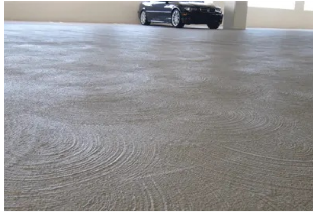
Figura 05 - Acabamento Recusado
